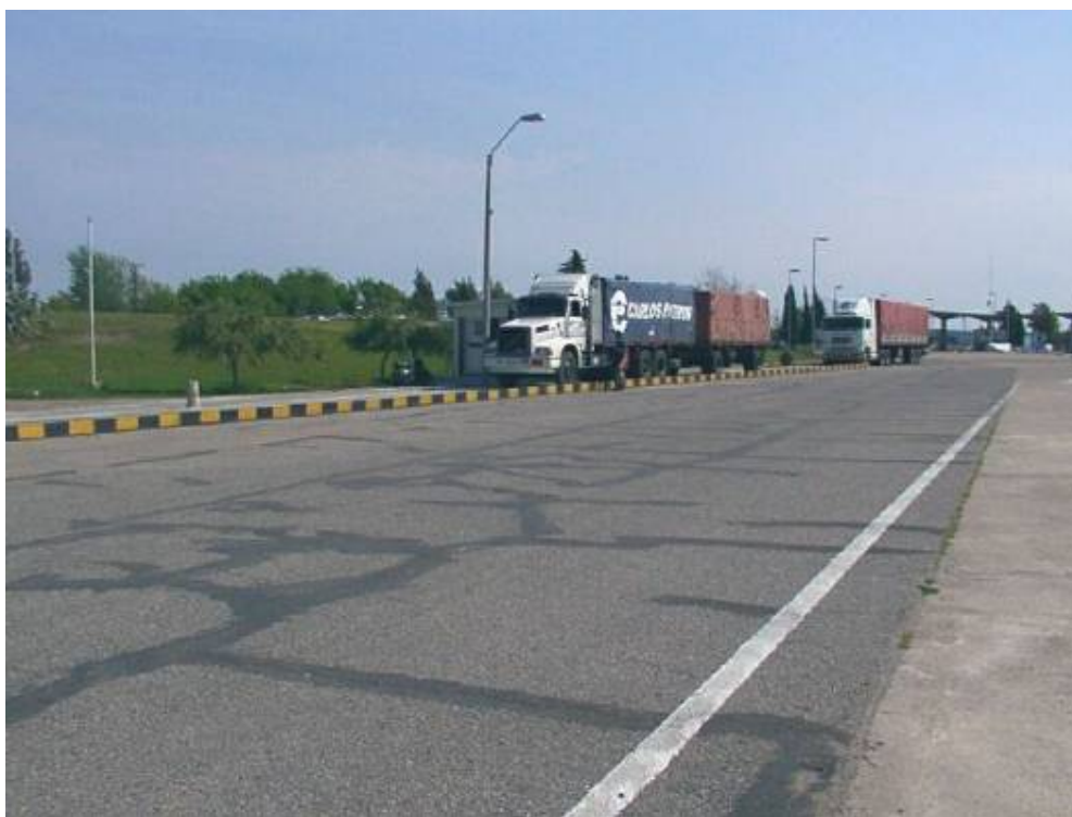
Vista de la salida de los camiones desde el puente a la báscula del lado uruguayo.
