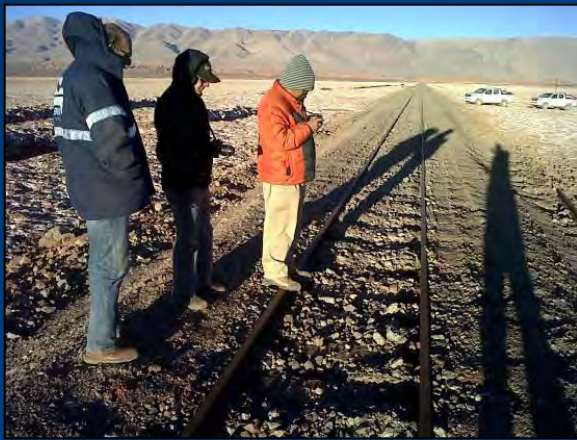
Inspección de vías
