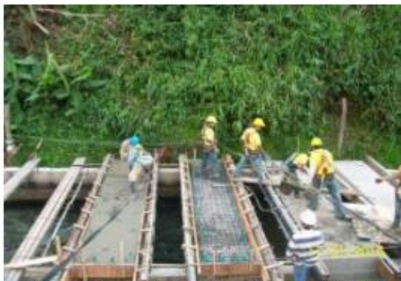
INTERVENCIÓN CANAL ABIERTO, ADUCCIÓN – NUEVO LIBARÉ
