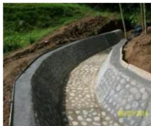
MANEJO DE AGUAS SUPERFICIALES CANAL
