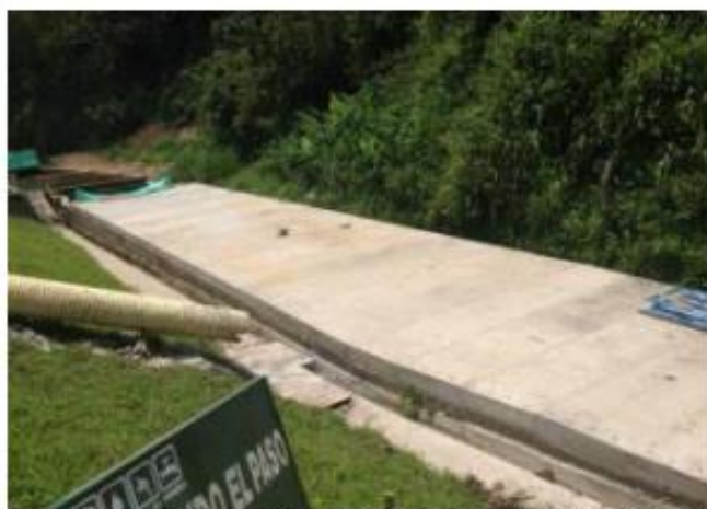
VISTA GENERAL CONSTRUCCION PLACAS SOBRE CANAL ABIERTO K0+140 - K0+302
