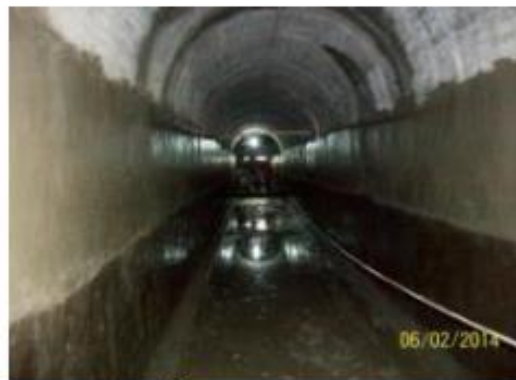
INTERVENCIÓN CANAL (BOX CULVERT) – NUEVO LIBARÉ
