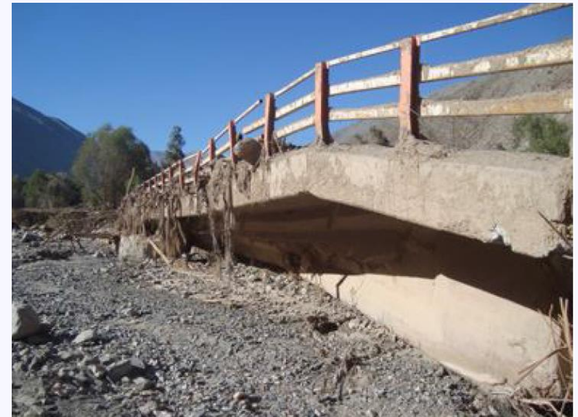
Estado final de la estructura
