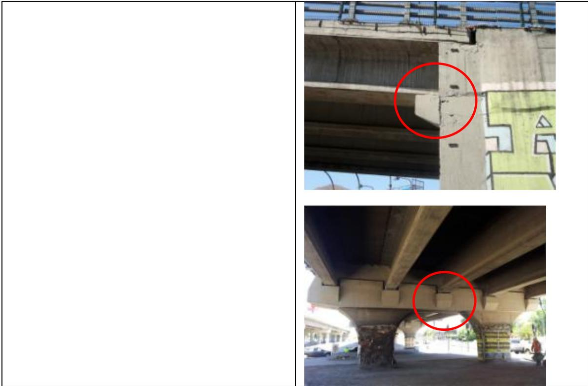
**RESTRICCIÓN DE MOVIMIENTOS VERTICALES DE TABLEROS Y/O VIGAS**
