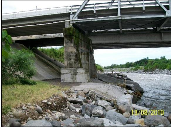
**Rompimiento de la protección de pila**
