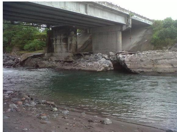
**Problemas de socavación en ambos estribos, siendo crítico el del puente metálico, por ser el expuesto a aguas arriba**
