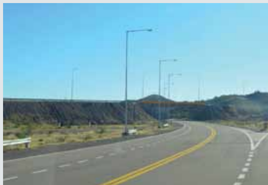
Empalme RN 40 y RN 150.
