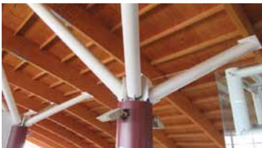
**Figura 436.** Detalle anclaje de estructura metálica a columna de hormigón
