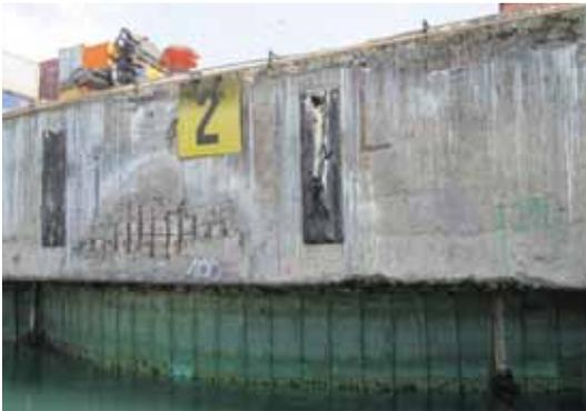
**Figura 4134.** Estado del hormigón de losa muelle Sitio 2.
