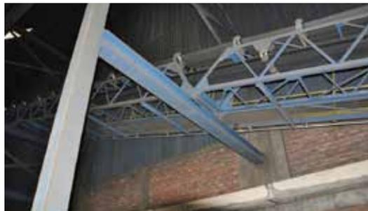
**Figura 4148.** Estructura de soporte correa transportadora a la salida del almacén de minerales
