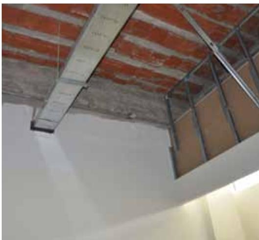
**Figura 4212.** Anclaje de escalerillas y tabiquerías
