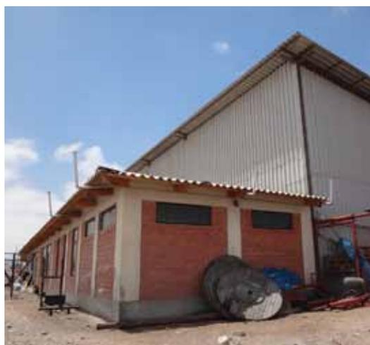
En la figura 4241 se observa parte de la estructura lateral y de techumbre que se proyecta por sobre el garaje. Se observa que la estructura no cuenta con arriostres diagonales.
