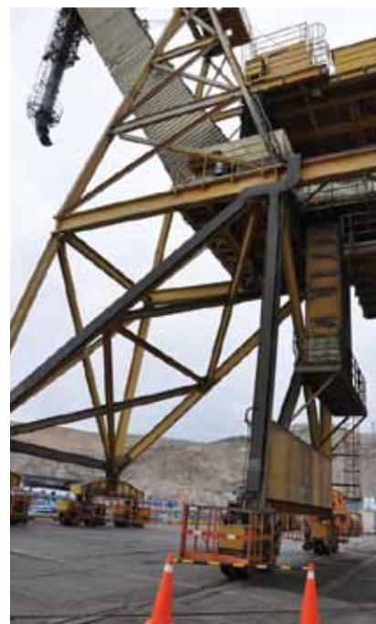
**Figura 4169.** Apoyo móvil Ship Loader
