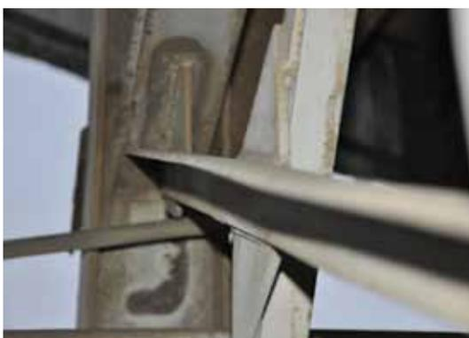
**Figura 4157.** Fisura en perfil estructura de soporte correa transportadora
