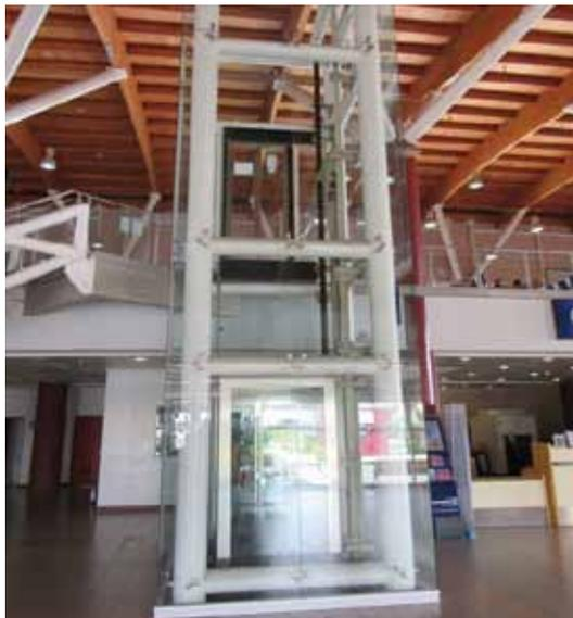
**Figura 443.** Conectores metálicos para sujeción de vidrio perimetral ascensor
