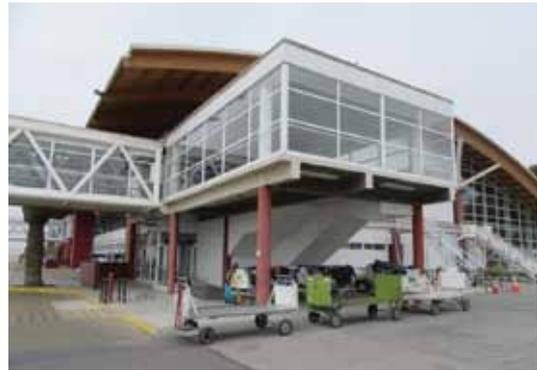
**Figura 426.** Trazado de junta de dilatación entre ambas estructuras de marcos
