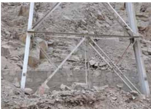
**Figura 4153.** Daño en perfil estructura de soporte correa transportadora
