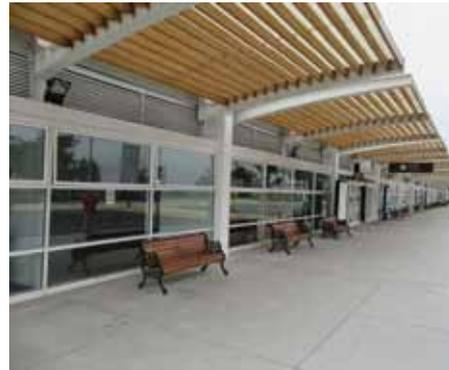
**Figura 422.** Conexión techo en voladizo en viga del marco resistente
