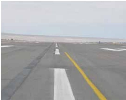
**Figura 4236.** Desgaste pavimento zona de contacto avión Pista de Aterrizaje
