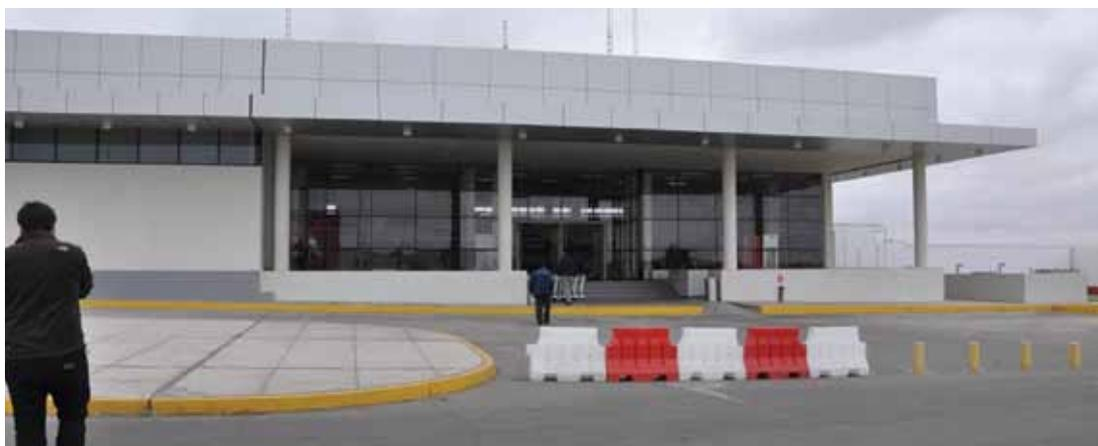
La figura 4203 muestra el hall de acceso al Terminal, el cual da acceso a los counters de las aerolíneas. Consiste en una estructuración de marcos de doble altura que utilizan muros vidriados como cierre perimetral.
