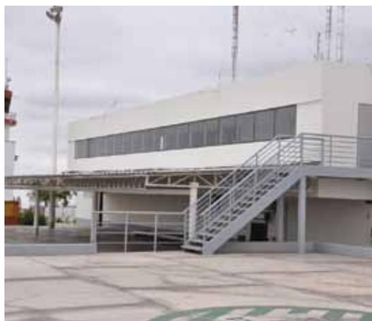
En la figura 4216 se muestra la estructuración del techo con tijerales reticulados conformados por canales y ángulos, el cual tiene un apoyo en la viga de la losa del Terminal y el otro en una columna metálica de sección tubular en el otro extremo.
