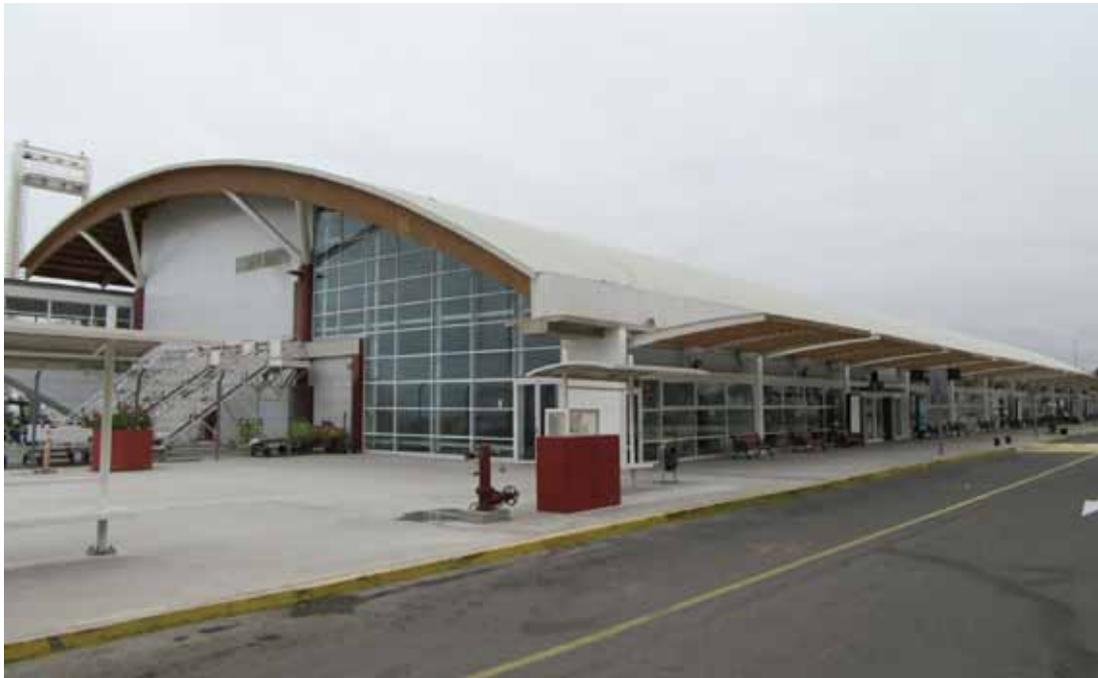
La estructura sismorresistente consiste en un sistema de marcos de concreto reforzado de un piso y columnas en volado que sirven de apoyo a una cubierta de madera laminada. La figura 418 muestra una vista en planta de la estructura del Terminal de Pasajeros que incluye esquemáticamente la disposición las columnas rectangulares y circulares que conforman el sistema de marcos.
