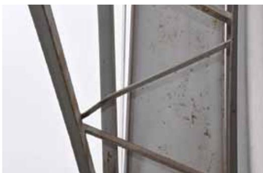
**Figura 4156.** Pandeo perfil estructura de soporte correa transportadora
