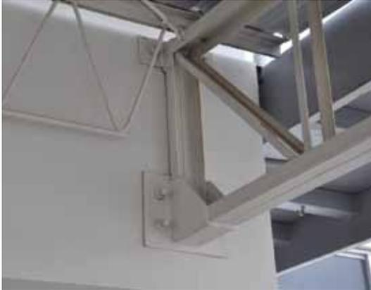
**Figura 4218.** Detalle conexión diagonal de techo
