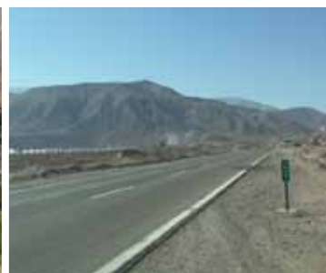
Figura 96. Acceso Planta Fotovoltaica (Km 57)
