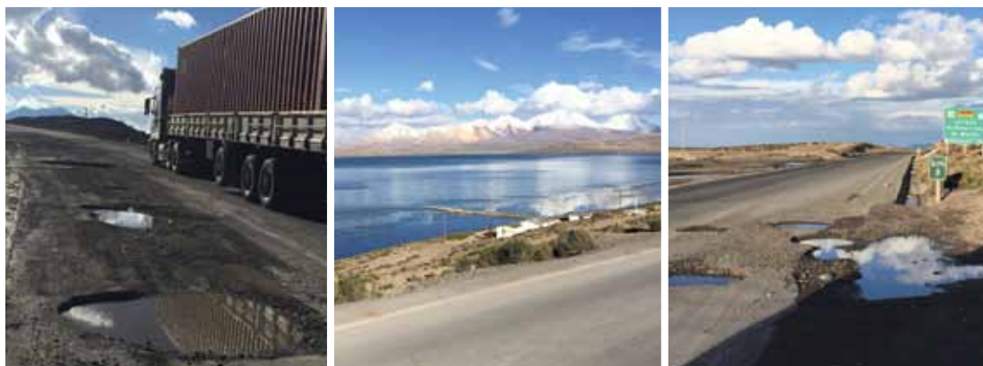
Figura 103. Tramo 10. Baches, Lago Chungurá, límite con Bolivia (Km 192)
