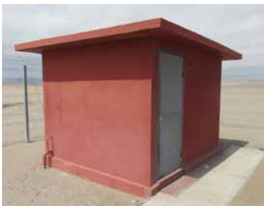
Figura 34. Sala eléctrica sistema de impulsión
