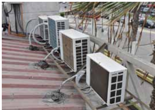
Figura 51. Estructura metálica soportante
