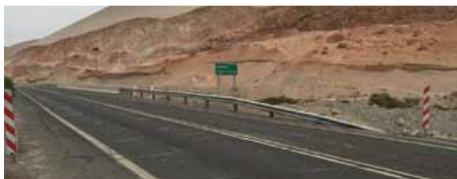
Figura 93. Puente Santa Lucia (aprox. Km 6)
