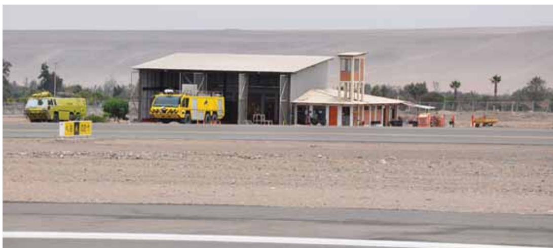
Figura 44. Vista cuartel S.E.I.
