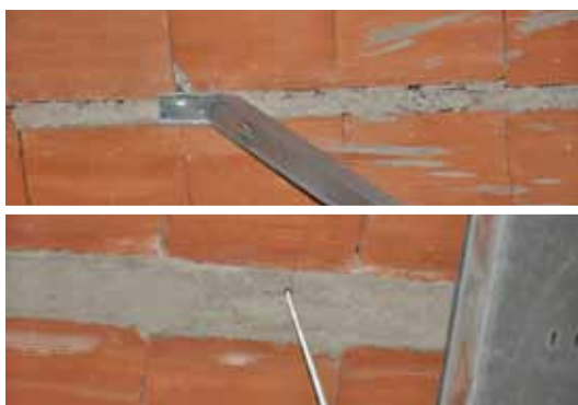
Figura 39. Anclaje de escalerillas y tabiquerías
