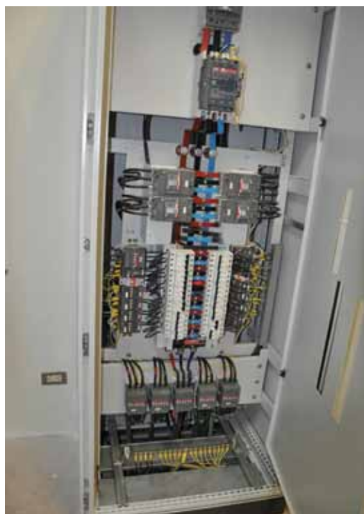
Figura 42. Equipo de comunicaciones sin anclaje
