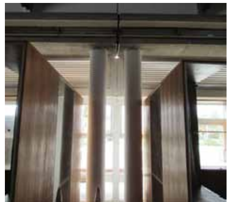
Figura 28. Columnas de hormigón armado en la zona de la junta de dilatación
