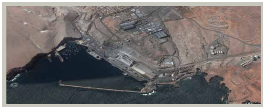
Figura 20. Vista general del Puerto de Matarani
