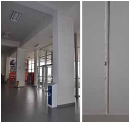
Figura 37. Junta estructural entre estructura original y remodelada
