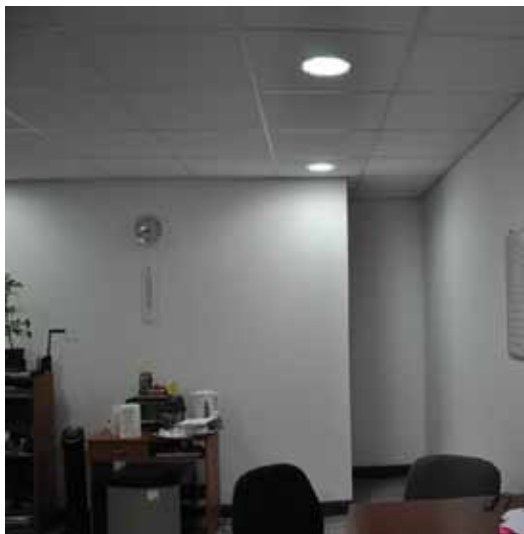
Figura 76. Ejemplos de vulnerabilidad sísmica de tabiquerías
