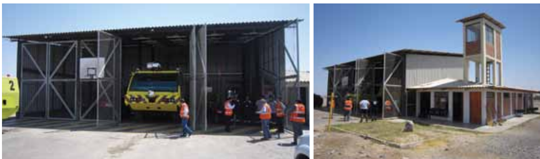
Figura 14. Vista general del cuartel SEI – Aeropuerto Tacna, Perú
