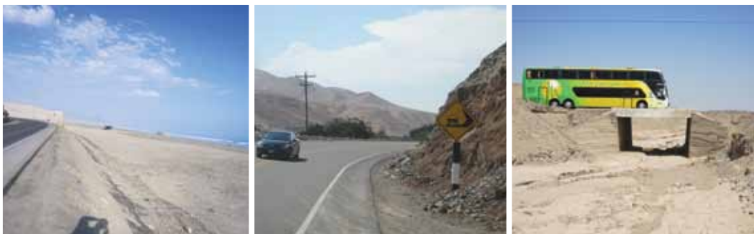
Figura 105. 1. Trazado de carretera cercana a borde costero - 2. Trazado en terraplén y zona de caída de materiales - 3. Obra de arte que podría afectar transitabilidad en caso de ser dañada
